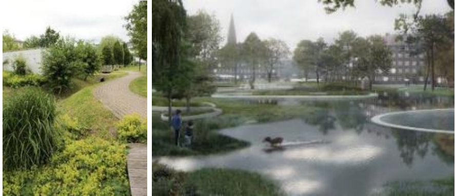
Exempel på skyfallsåtgärd i bebyggd miljö med skyfallsdike (t.v.) respektive mångfunktionell skyfallsyta i park (t.h.). Källa: Ramböll
