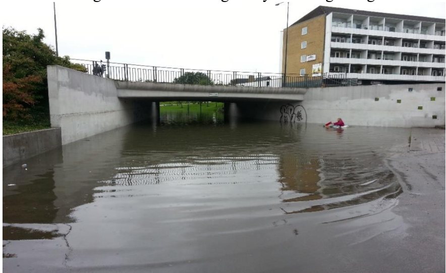
Översvämmad GC-tunnel i Malmö i samband med skyfallet år 2014. Foto: Stefan Milotti
